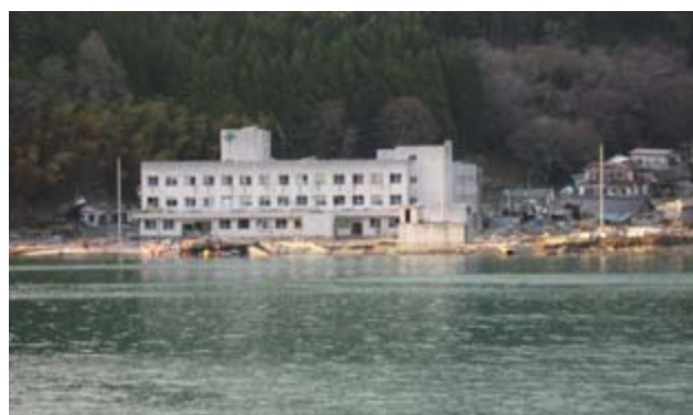
石巻市立雄勝病院 ©東北大学大学院医学系研究科・地域保健支援センター
