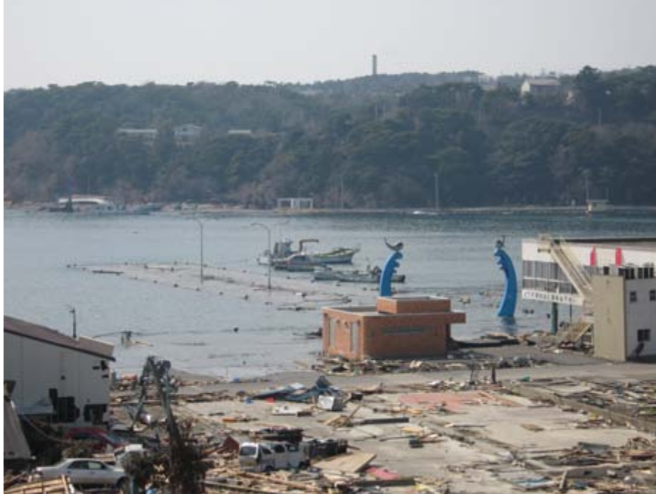
フェリーターミナル(石巻市鮎川浜) ©東北大学大学院医学系研究科・地域保健支援センター
