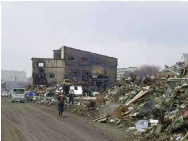
被災地域(石巻市門脇地区)
