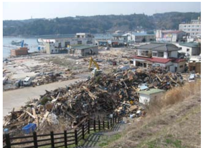
津波で被災した石巻市鮎川浜
